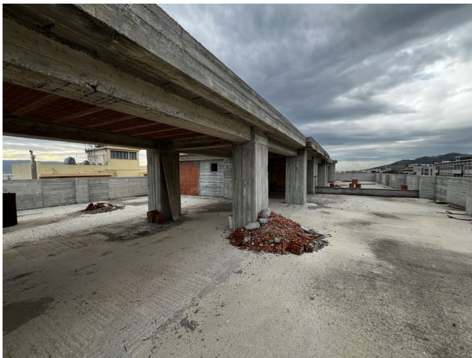
Stato di fatto del costruendo fabbricato (Fig. 141 part. 28) - Terrazza praticabile parzialmente coperta
