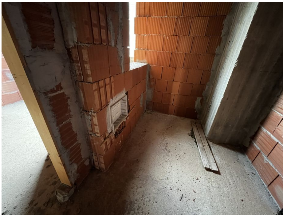
Stato di fatto del costruendo fabbricato (Fig. 141 part. 28) - uniche tracce di impianti (scarichi e cavedi)
