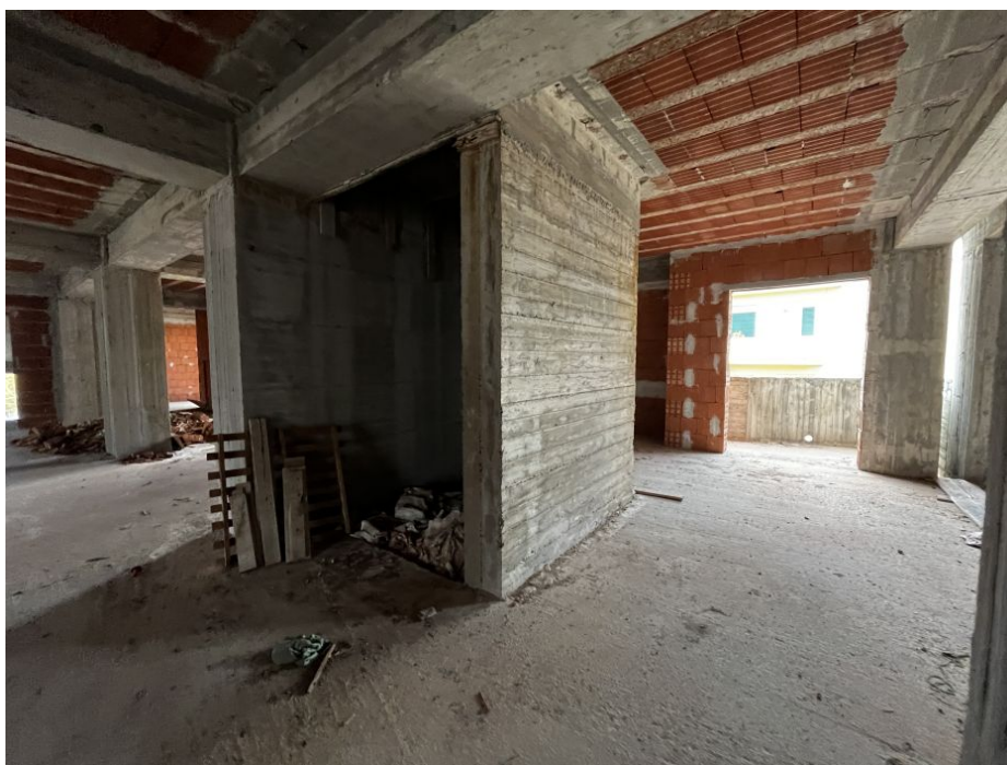
Stato di fatto del costruendo fabbricato (Fig. 141 part. 28) - struttura in c.a. per un vano ascensore
